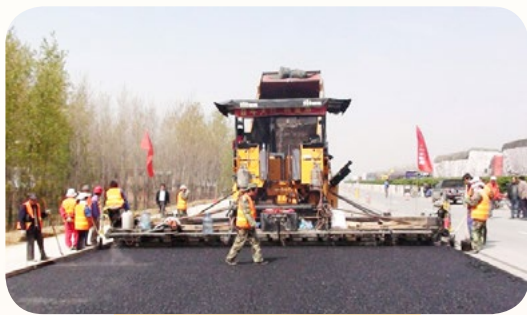
张俊学参建的柳武项目摊铺现场
