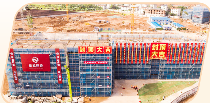
福建连城教育补短板PPP项目——一中莲北分校1#教学楼主体封顶
