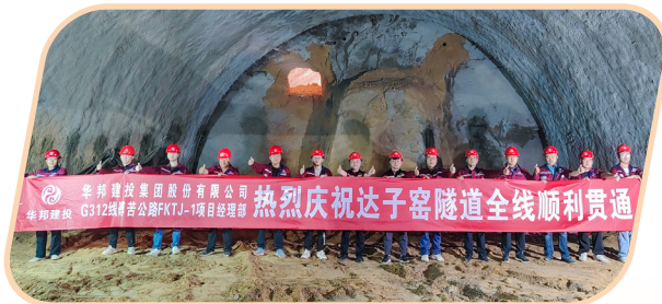
甘肃 G312 线傅苦项目达子窑隧道双线贯通
