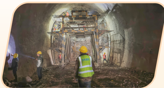
新疆那巴项目艾肯隧道斜井复工建设
