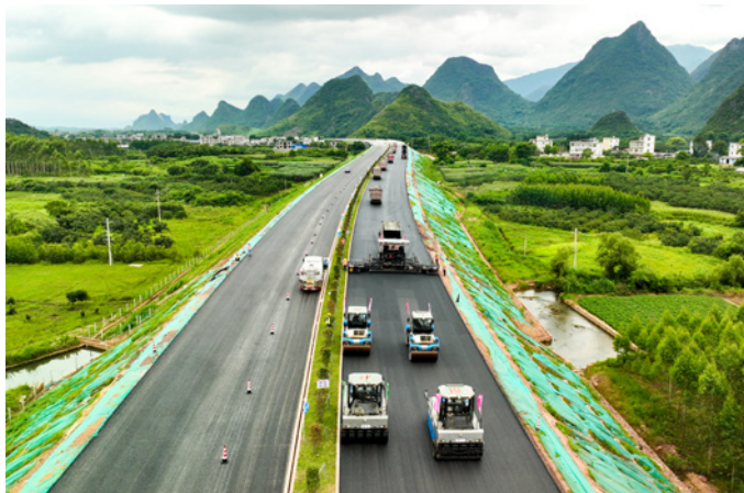
路面无人摊铺机群热火朝天施工中
