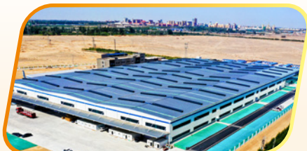
甘肃凤渡厂房项目施工已基本完成
