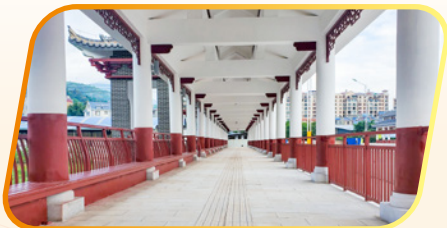
云南富民市政项目螳螂川瓦窑跨河大桥完成仿古连廊工程初验
