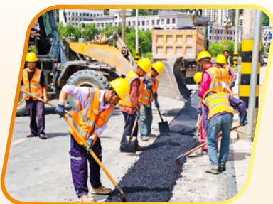
甘肃康县天然气项目现场施工人员正在摊铺沥青路面
