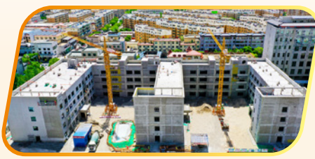
甘肃永昌一中项目教学楼整体工程已完成 85%
