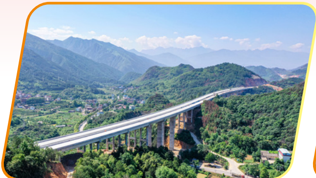
广西灌平高速项目处于全力冲刺阶段，路基、路面、桥梁、隧道、房建、机电、绿化等关键点位正紧锣密鼓展开建设
